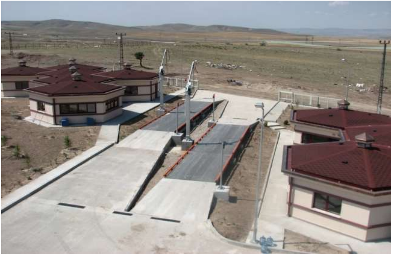
30.000 TON KAPASİTELİ ÇELİK SİLO TESİSLERİ 60 TONLUK TAŞIT KANTARLARI, OTOMATİK NUMUNE ALMA CİHAZLARI, LABORATUVARLAR, İDARİ VE SOSYAL BİNALAR GÖRÜNÜŞÜ
