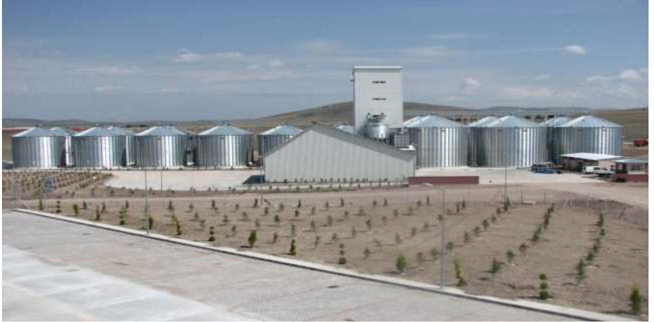
30.000 TON KAPASİTELİ ÇELİK SİLO, TREMİ, MALZEME DEPOSU, GÜVENLİK BİNASI, MAKİNA BİNASI GÖRÜNÜŞÜ
